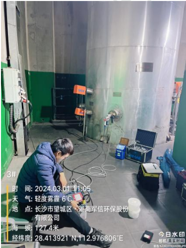
3#炉净烟气排放口
