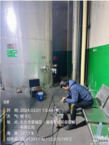
6#炉净烟气排放口
